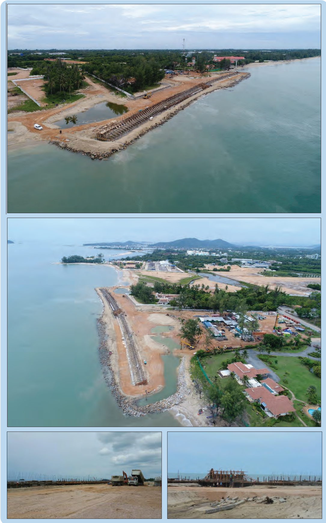
รูปถ่ายที่ 4.6-1 ภาพการก่อสร้างเขื่อนฯ บริเวณหาดทรายแก้ว อำเภอสิงหนคร จังหวัดสงขลา
