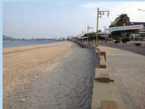
ที่มา : ภาพถ่ายกำแพงคอนกรีตกันคลื่น บริเวณอ่าวประจวบ อำเภอเมือง จังหวัดประจวบคีรีขันธ์ (ง) กำแพงป้องกันคลื่นริมชายหาด
