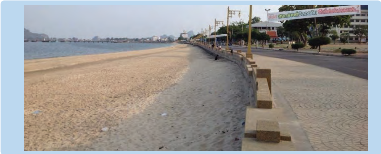
ที่มา : ภาพถ่ายกำแพงคอนกรีตกันคลื่น บริเวณอ่าวประจวบ อำเภอเมือง จังหวัดประจวบคีรีขันธ์
